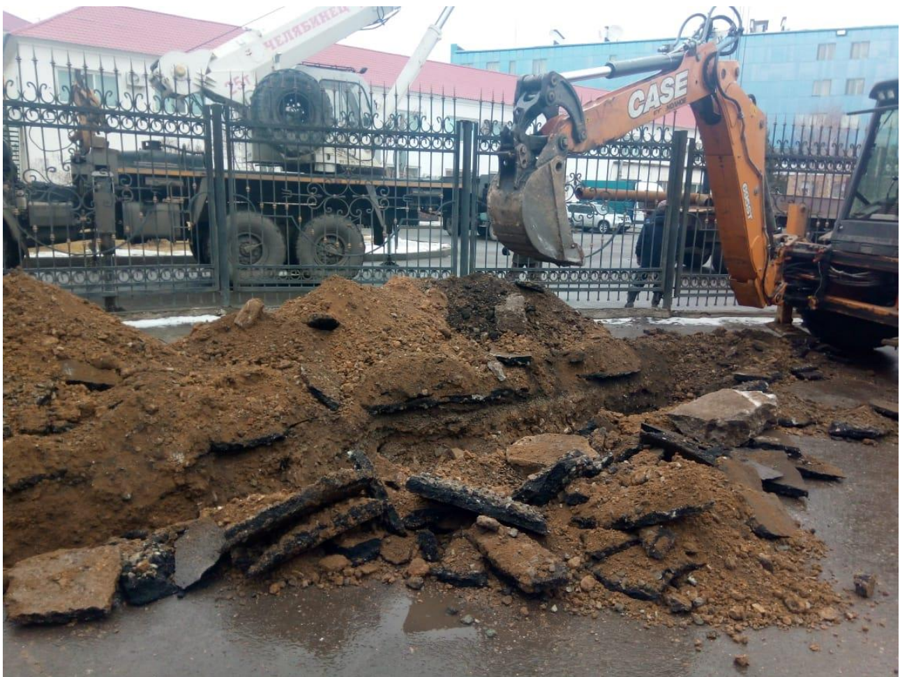
Тепловые сети площадь Metallургов 1
