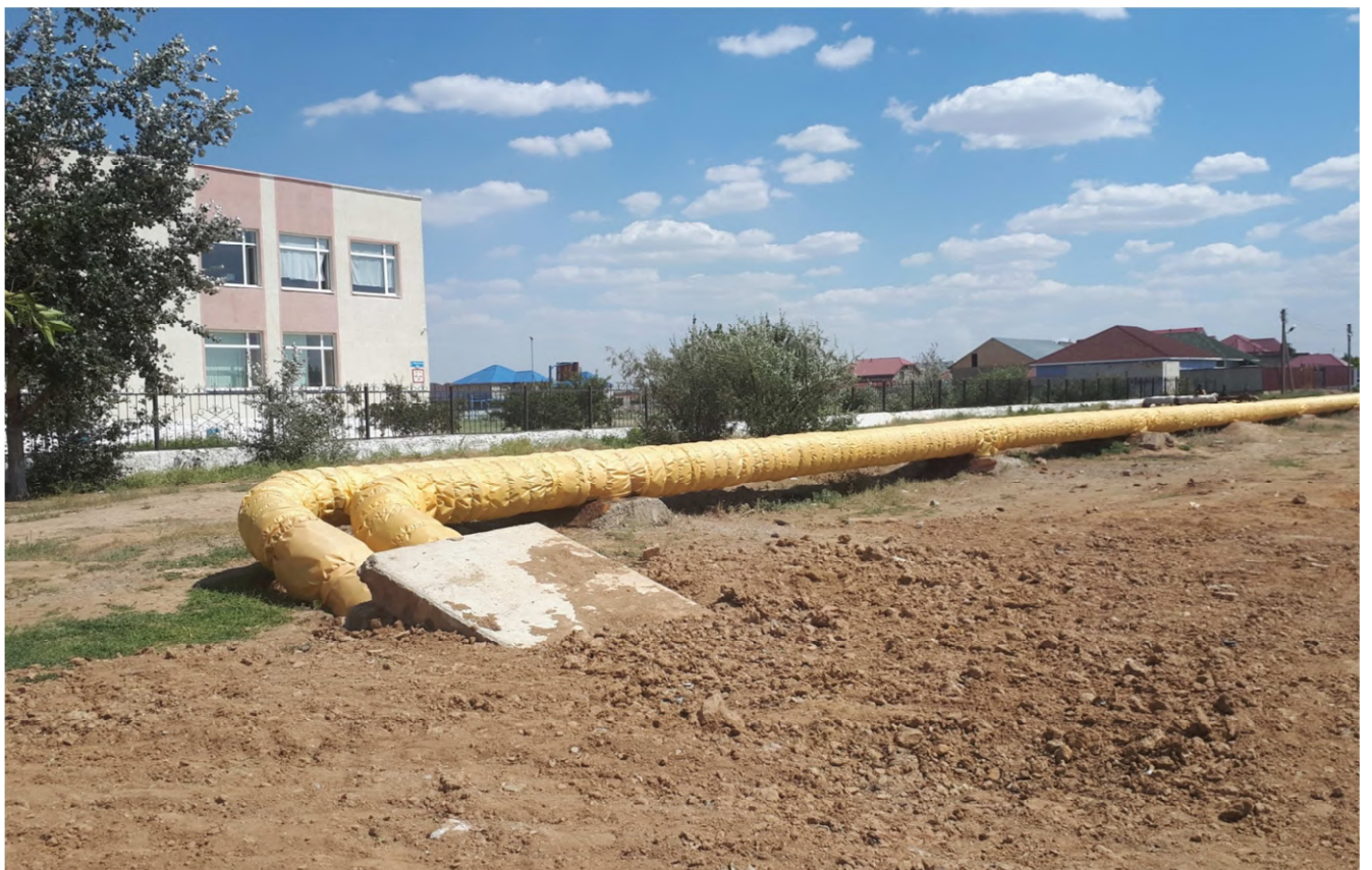
9. Капитальный ремонт теплосети подводящая от выхода из канала до ул. Маргулана– закончен (июль)
