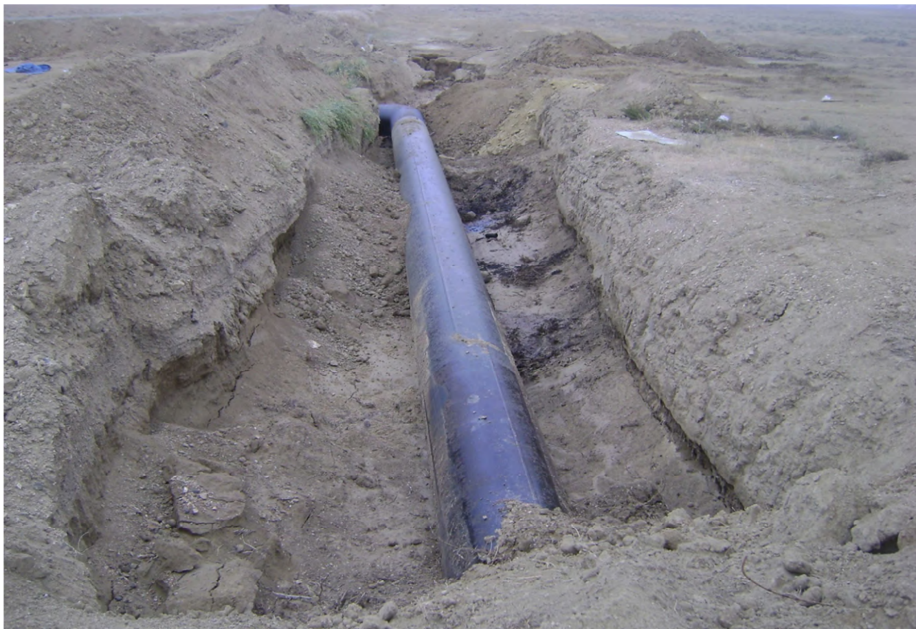
12. Замена аварийных участков Уйтас-Айдосского водовода – в работе
