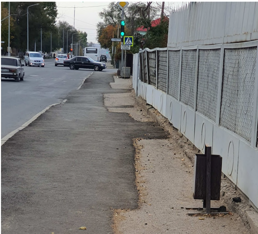
17. Капитальный ремонт - Поливочного водопровода по ул. Абая от ул.Смайлова до ул.Байконурова – закончен (май)
