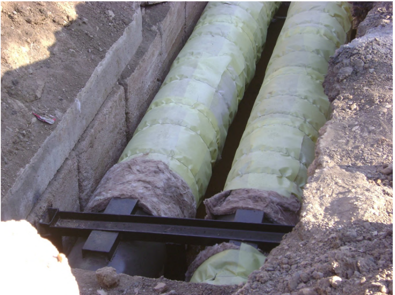
3. Капитальный ремонт тепломагистрали №9: прямой и обратный трубопровод ул. Байконурова от ТК-3 до ТК-4 – в работе
