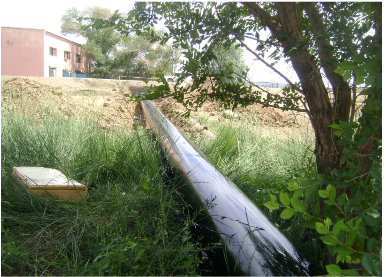
16. Капитальный ремонт - Поливочного водопровода по ул. Холмецкого от ул. Холмецкого 60 до теплопункта н/с №9 – закончен (июнь)
