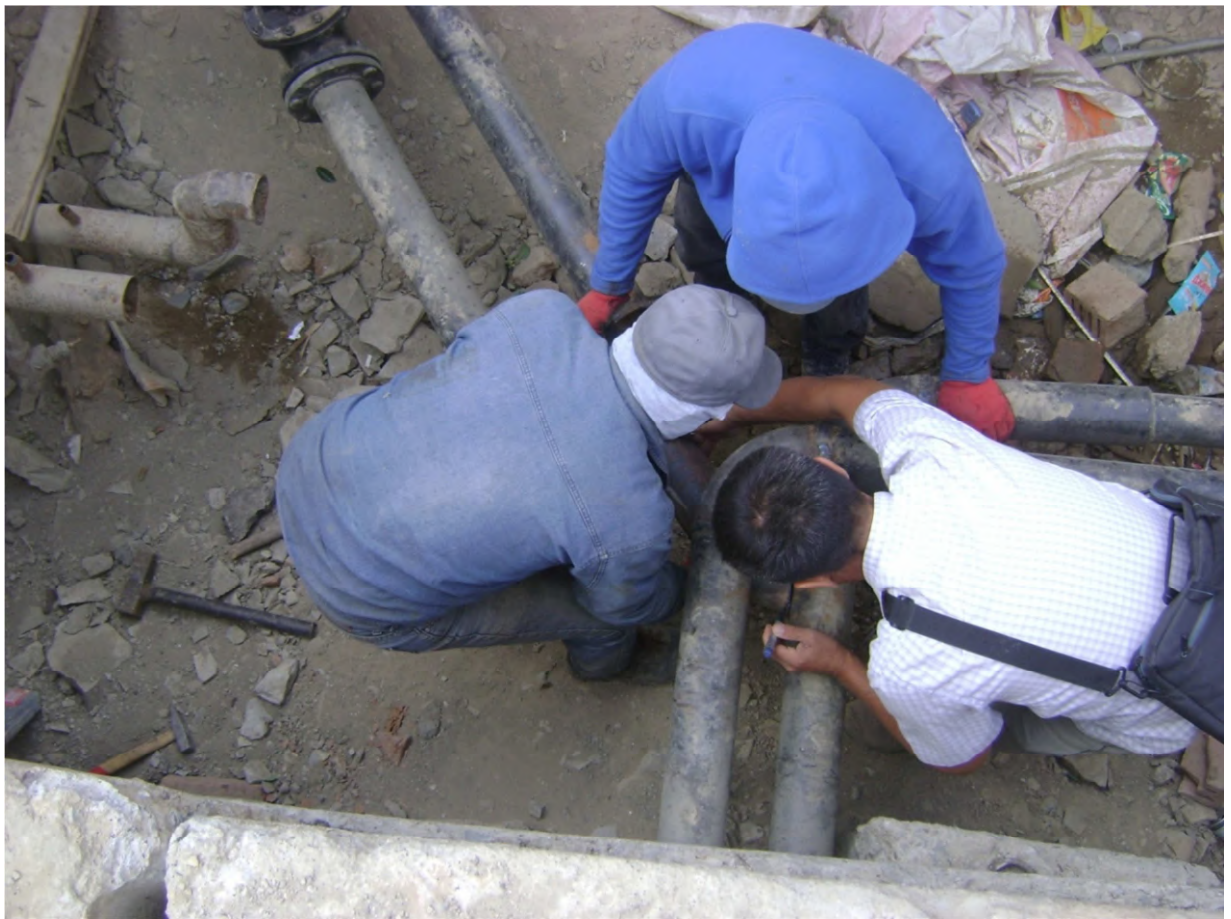
6. Капитальный ремонт теплосети от ТК-20 до ул. Алашахана 43 – закончен (сентябрь)
