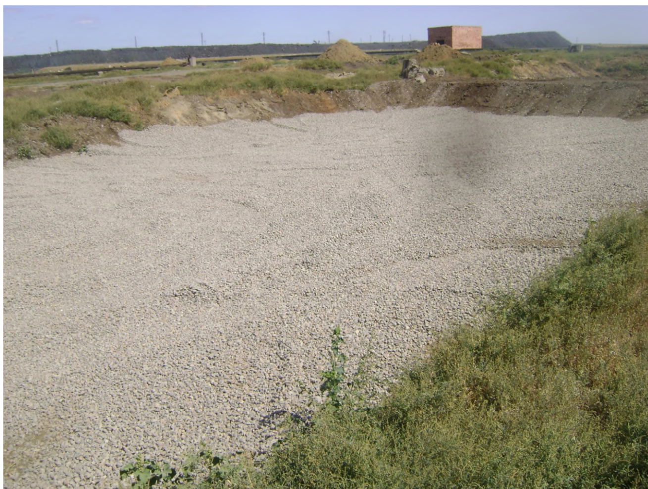
13. Капитальный ремонт - Канализационный коллектор на иловых площадках – в работе
