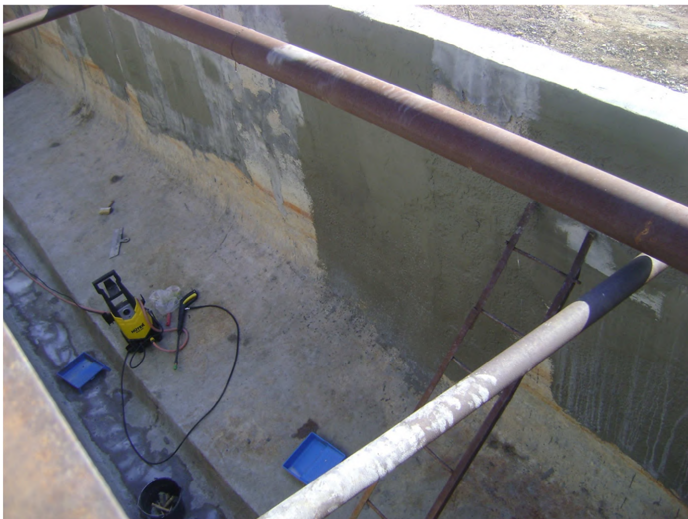
15. Реконструкция песколовок 2 линии – в работе
