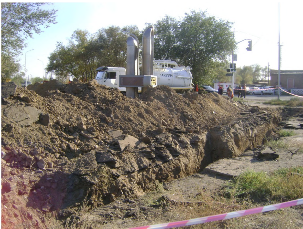
11. Капитальный ремонт - водопровода по ул.Абая от ул.Улытауская до ул.Сары-Арка– в работе
