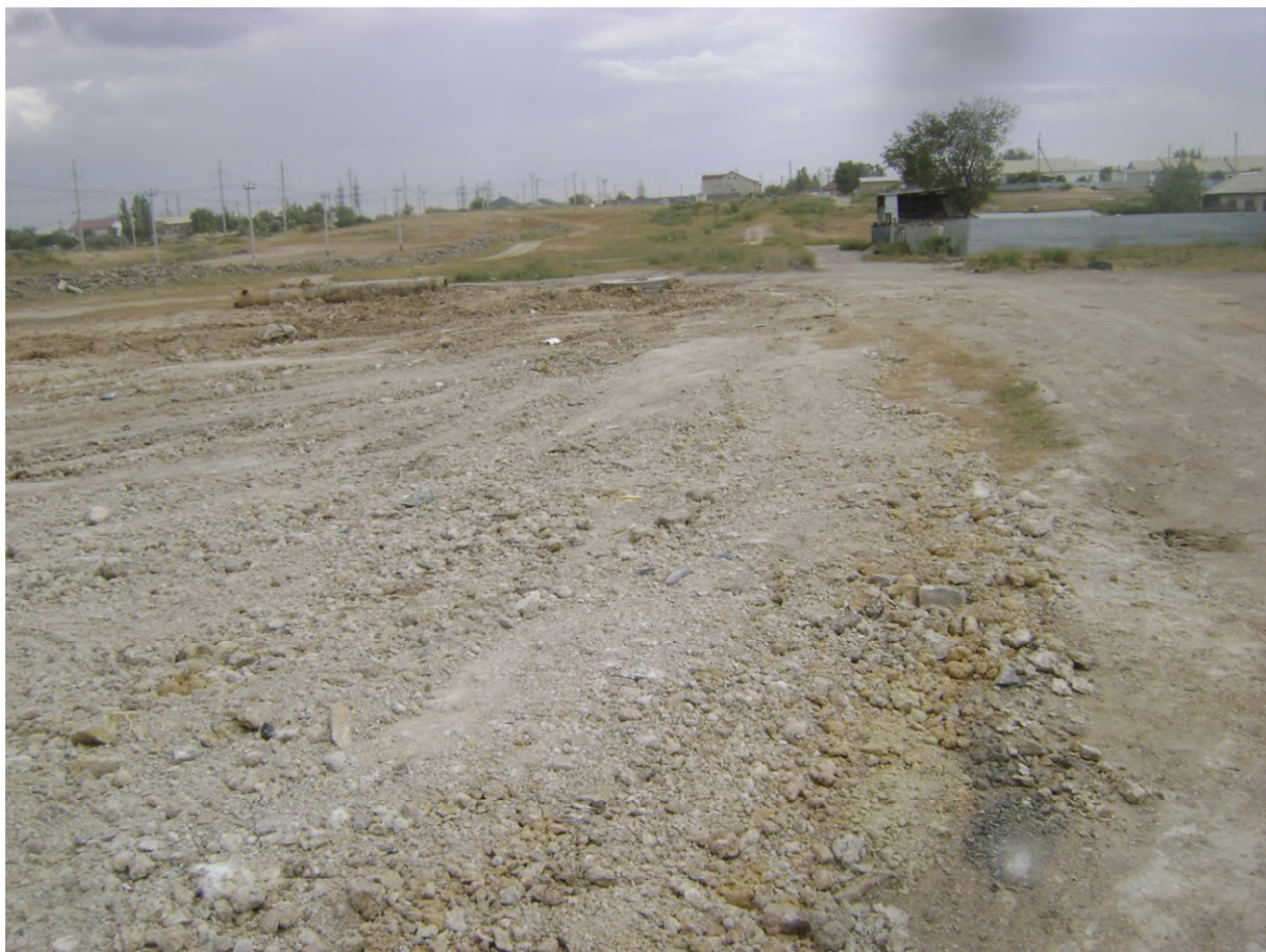
10. Капитальный ремонт - Старый северный водовод от ЦРП-5 до ул.Болмана – закончен (август)
