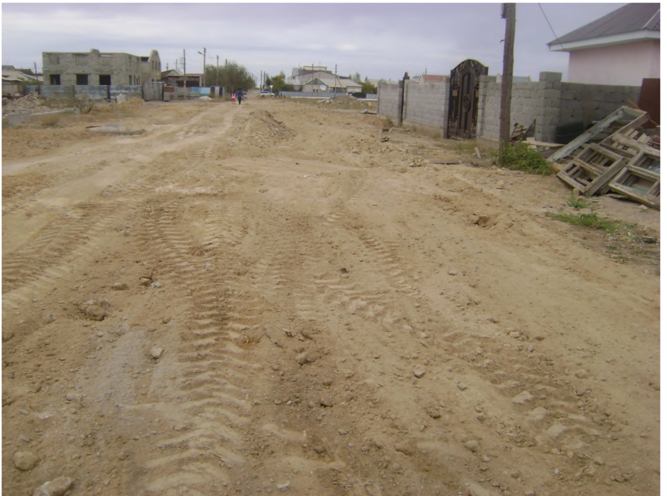
8. Капитальный ремонт теплосети по ул.Валиханова, между ул. Казакбаева и ул. Ауэзова – закончен (оформление документов)
