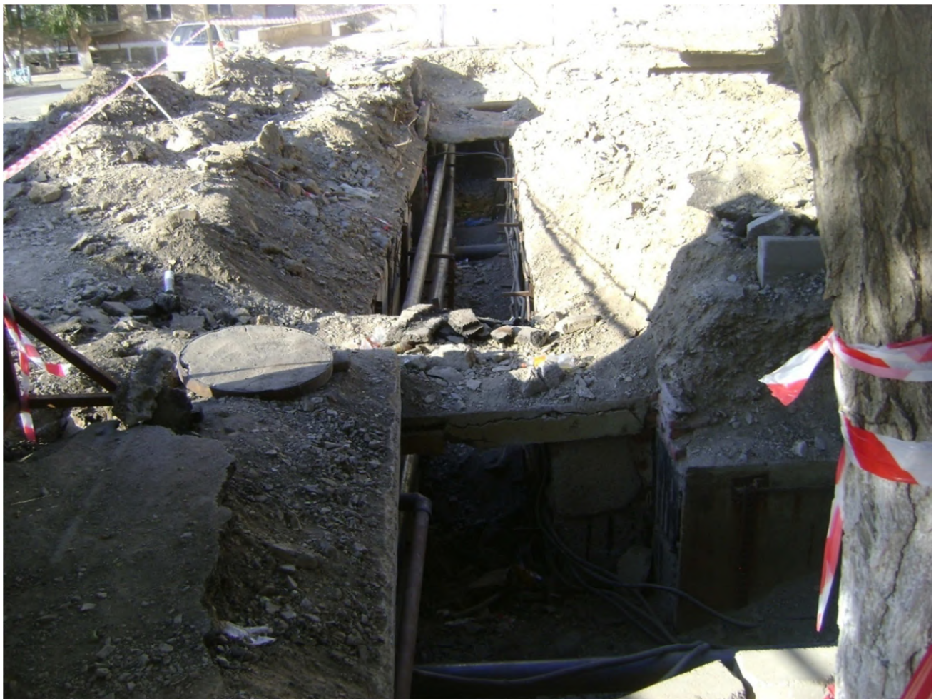
7. Капитальный ремонт теплосети от ТК-7 до ул. Женис 13 – в работе
